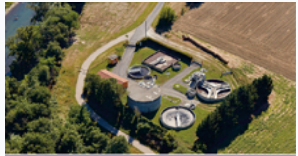
La station d'épuration Noé
