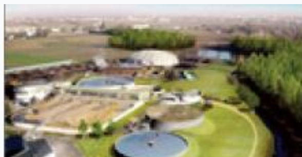
La station d'épuration Cugnaux
