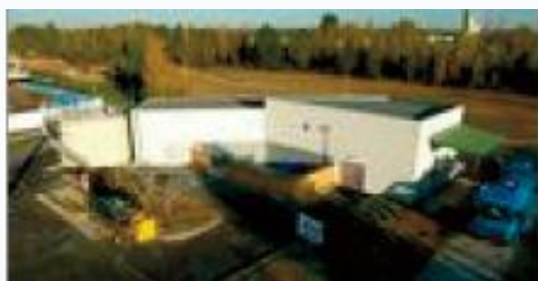
L'usine de traitement des sous-produits de l'assainissement
