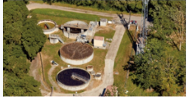
La station d'épuration Lavernose-Lacasse
