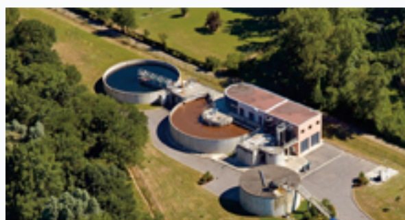
La station d'épuration Pins-Justaret
