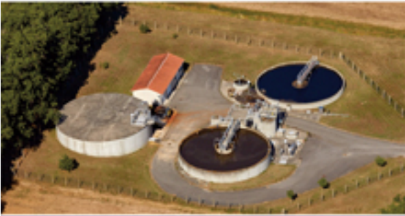
La station d'épuration Eaunes
