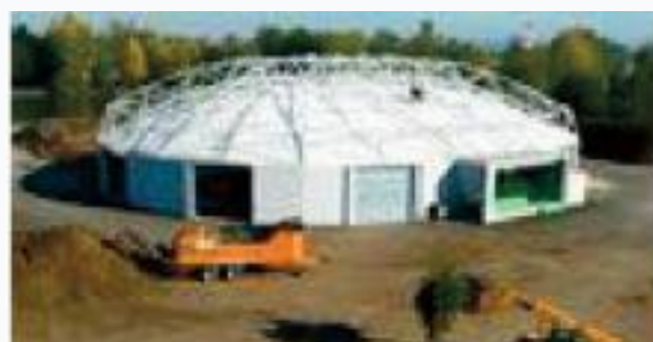
L'usine de compostage des boues
