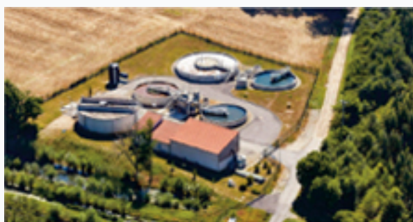
La station d'épuration Saint-Clar de Rivière
