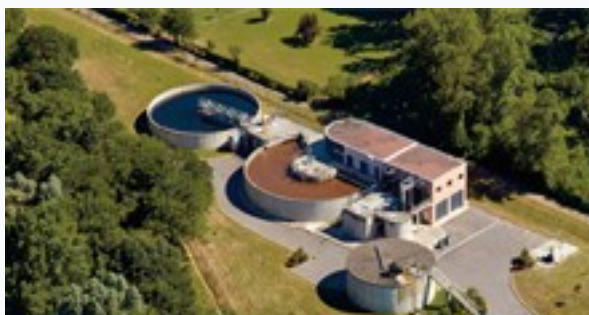
La station d'épuration Pins-Justaret
