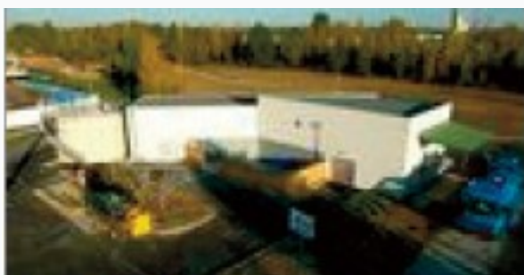
L'usine de traitement des sous-produits de l'assainissement
