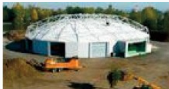
L'usine de compostage des boues
