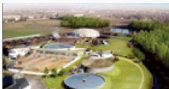
La station d'épuration Cugnaux
