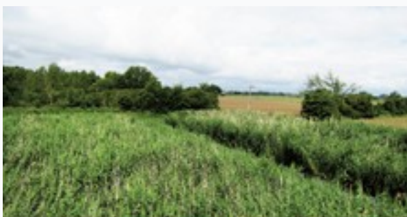
La station d'épuration Le Fauga
