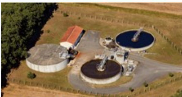
La station d'épuration Eaunes
