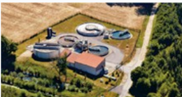
La station d'épuration Saint-Clar de Rivière
