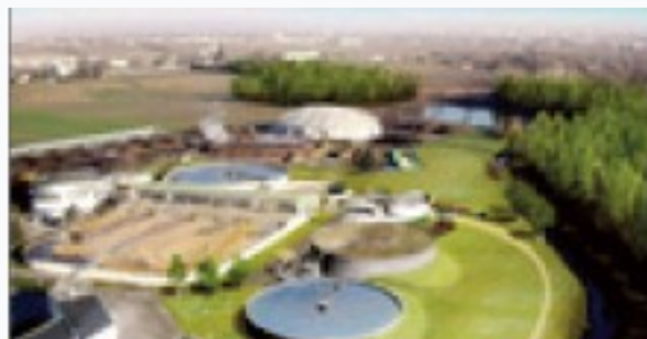
La station d'épuration Cugnaux
