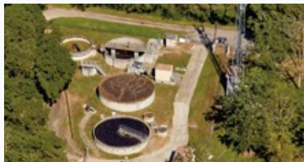
La station d'épuration Lavernose-Lacasse
