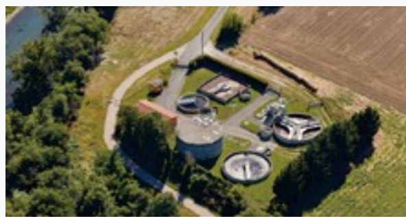
La station d'épuration Noé
