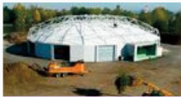
L'usine de compostage des boues
