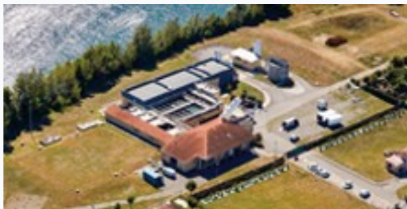
L'usine de production d'eau potable - Roques
