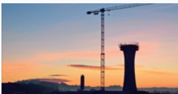
Le stockage de l'eau potable
