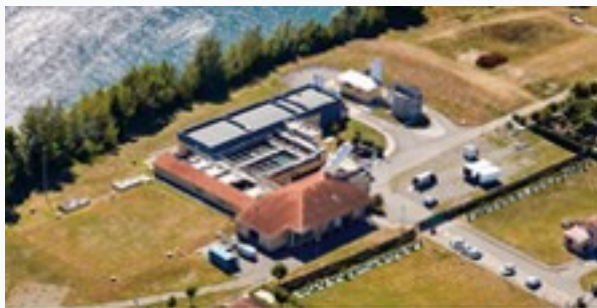
L'usine de production d'eau potable - Roques
