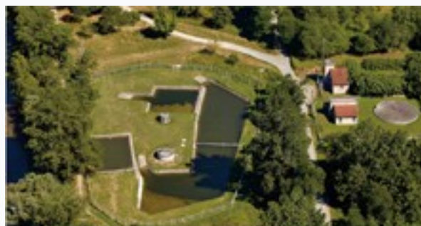
L'usine de production d'eau potable - Pinsaguel
