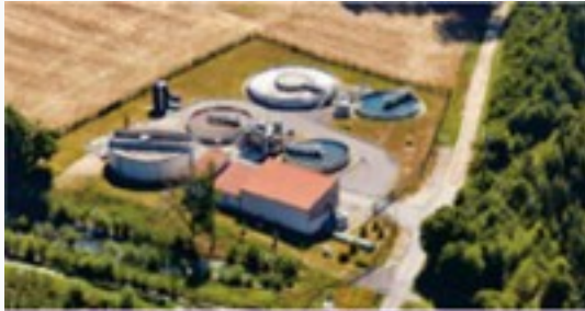
La station d'épuration Saint-Clar de Rivière
