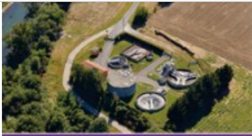
La station d'épuration Noé
