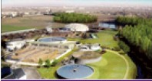
La station d'épuration Cugnaux
